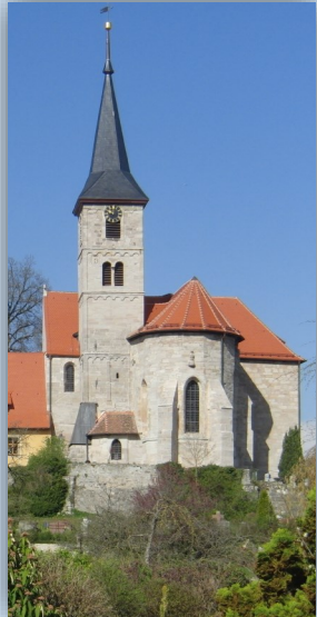
Südturm, 1735 um ein Stockwerk erhöht
